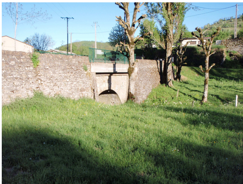
Le pont du Rieutord, Cubières
