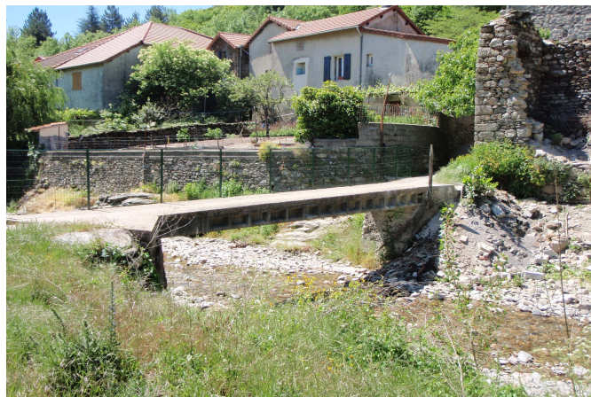
La passerelle à Saint-André-Capcèze
