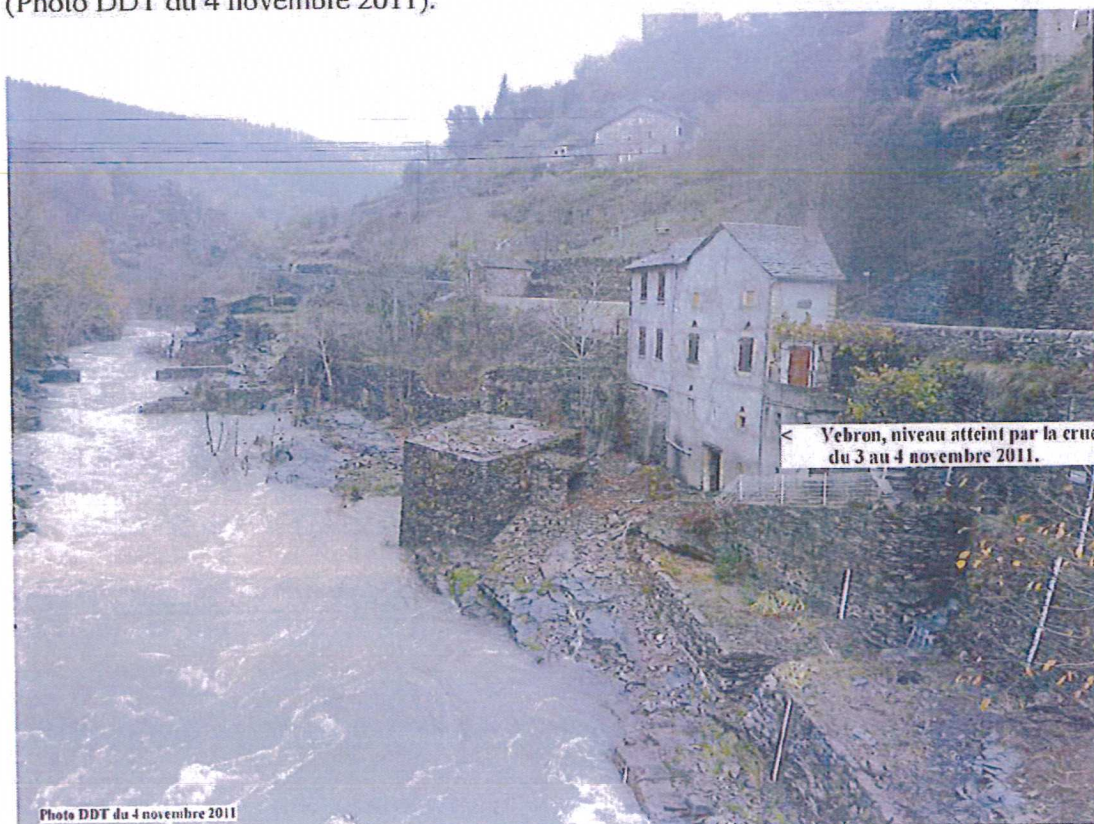
Ci-dessous, vue du pont, niveau atteint par la crue du 3 au 4 novembre 2011. (Photo DDT du 4 novembre 2011).
