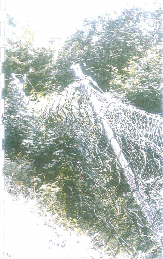
Photo 4.4. Saint Martin le Vinoux : filet ASM doublé grillage, poteaux et haubanage à l'aval du filet avec « bavette »
