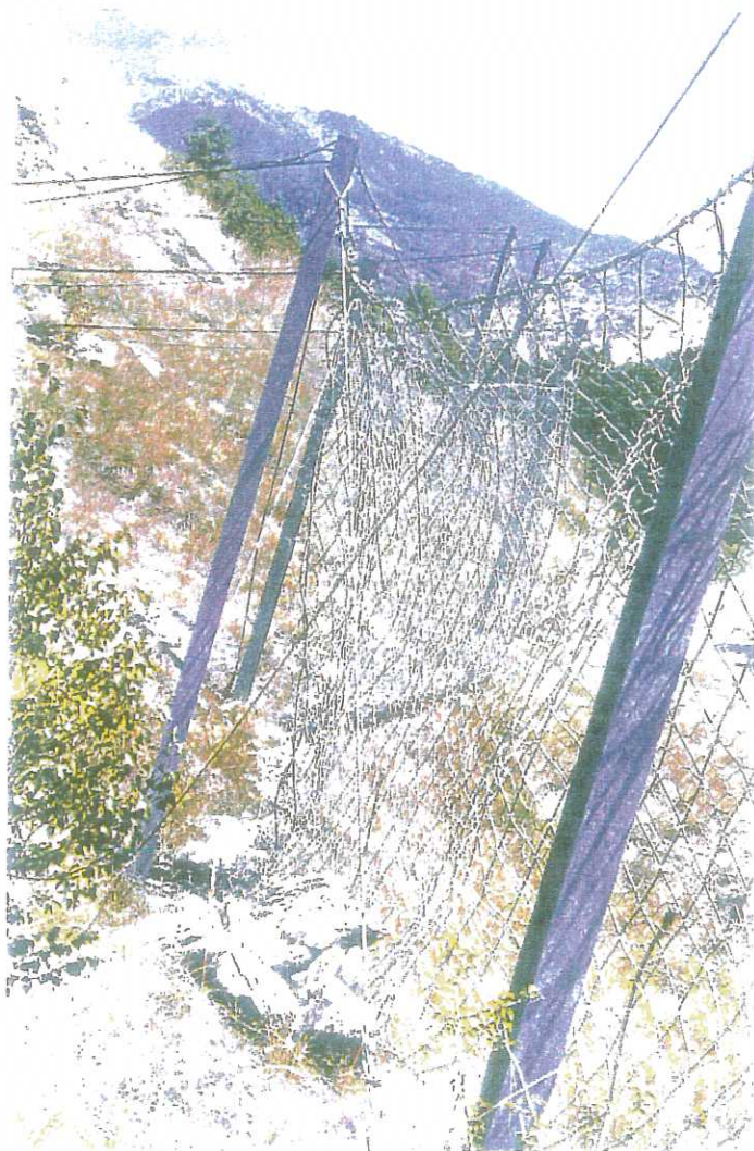
Photo 4.5. Centron: filet à maille hexagonale, profilés métalliques et haubanage à l'amont du filet
