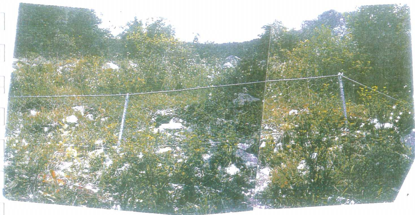
Photos 3.4. et 3.5. Barrière grillagée (hauteur 1 m) dans une pente d'éboulis, Aigebelette, RN 41
