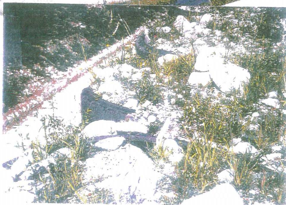
Photo 1.7. Disposition « en tuile » des ouvrages pour assurer le recouvrement ; pistes pour l'accès
