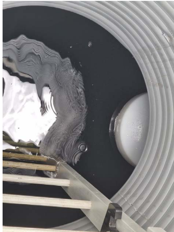
Robinet à flotteur sur l'arrivée au réservoir de Felgerolles
