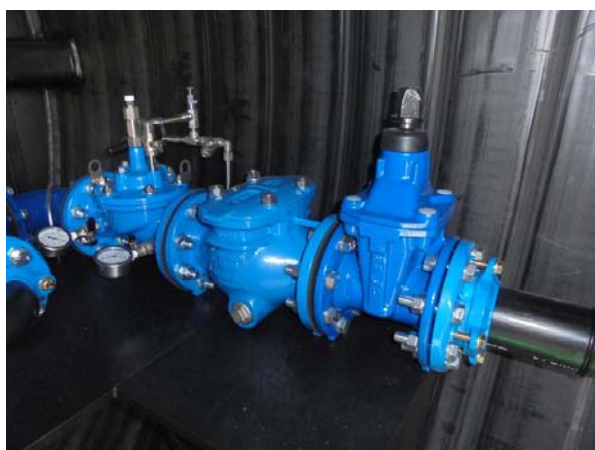
Vanne, boîte à filtre, réducteur de pression
