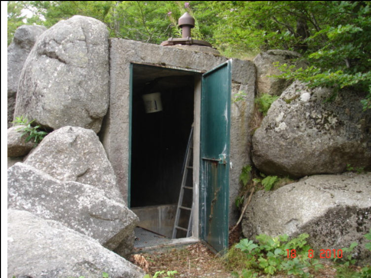
Vue extérieure de l'ouvrage de prise, la porte d'accès et le capot fonte avec une cheminée d'aération
