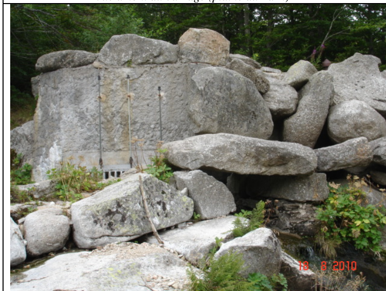
Vue extérieure de l'ouvrage et sa couverture par des blocs rocheux
