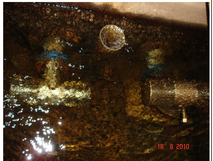
Vue des 2 départs avec les crépines Johnson
