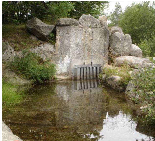
Vue extérieure de la prise d'eau et du béal
