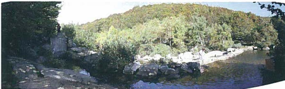
Photo 5 : Vue générale du captage : à droite le barrage, à gauche le canal de dérivation et le captage au fond (sur lequel est positionné la personne rouge)
