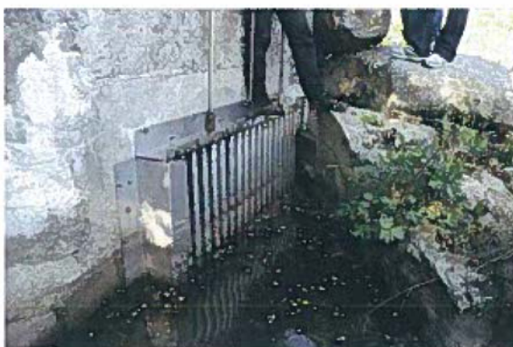
Photo 4 : Vue du barreaudage INOX
