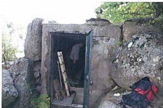
Photo 10 : Entrée du captage
