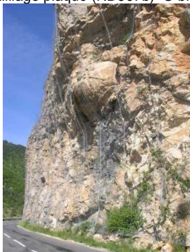
Exemple de confortement par enrochement (RN88, Mende)
