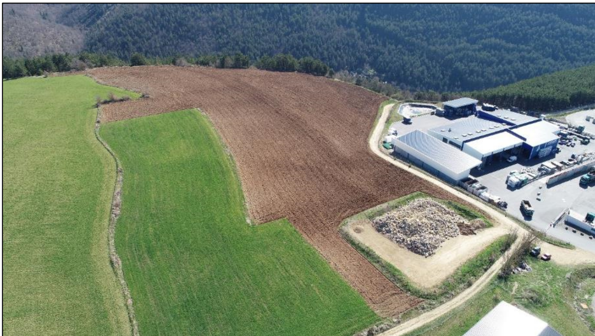
Figure 23: Photographie prise par drone du site de la future extension
