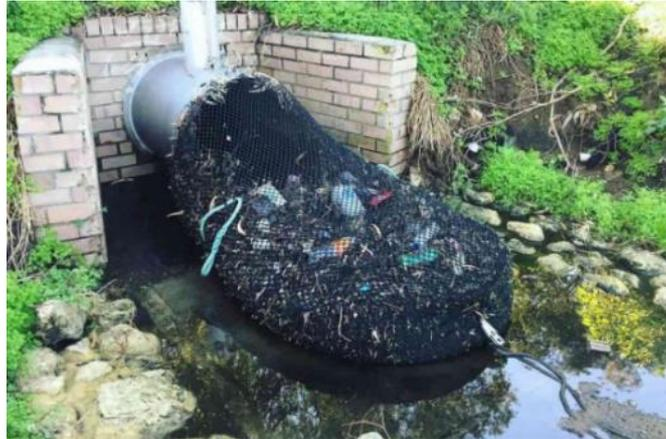
*Figure 60: Filet à déchets au niveau d'un exutoire pluvial*
