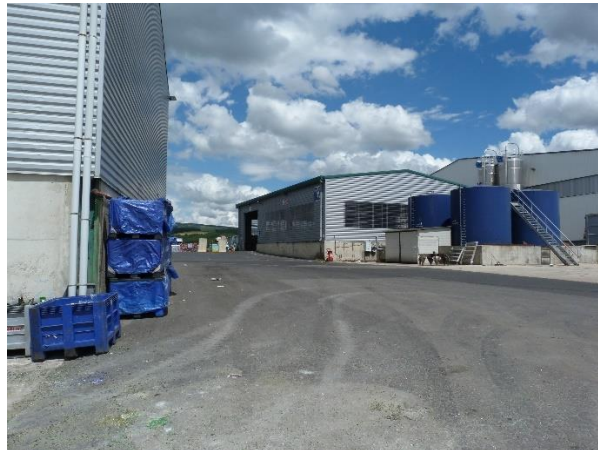
Figure 3 : vue du bâtiment B2
