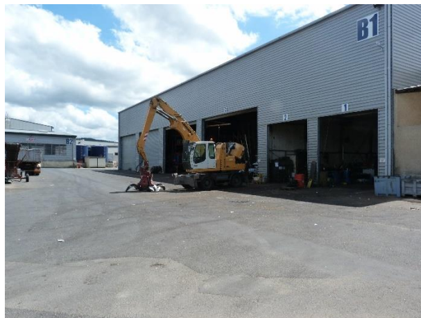
Figure 2 : vue du bâtiment B1
