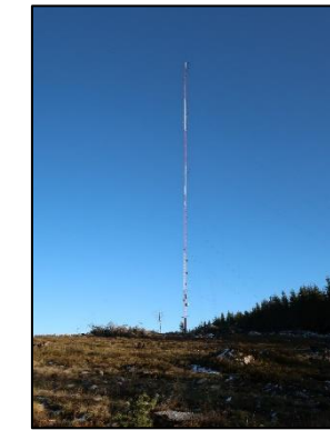
Mât de mesure sur la ZIP Source : Artifex 2019
