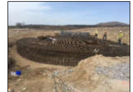
Montage de l'armature Source : Artifex 2018
