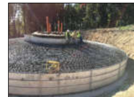
Montage de l'armature Source : Artifex 2018
