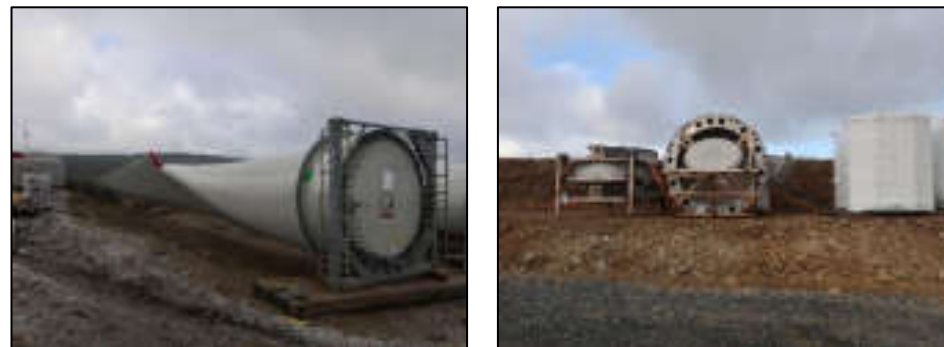
Stockage des éléments des éoliennes Source : Artifex 2018
