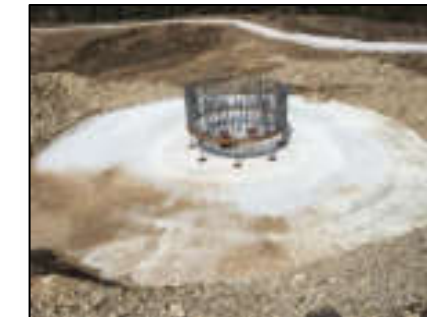
Montage de l'armature Source : Artifex 2018
