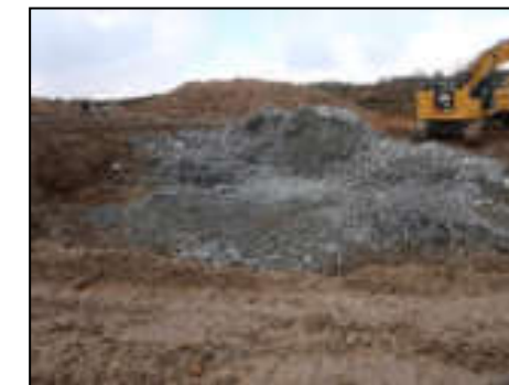
Démolition d'une fondation
