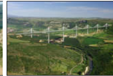
Vue sur le Viaduc de Millau Source : www.tourisme-aveyron.com
