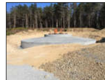
Fondation non remblayée Source : Artifex 2018
