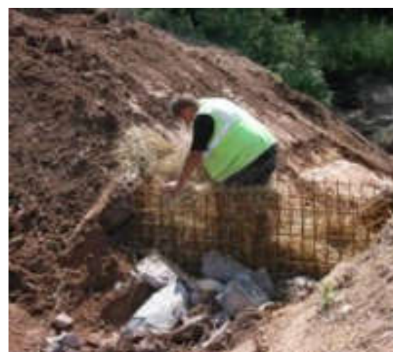
Mise en place de paille compactée par piétinement
