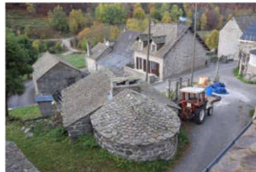
Exemple de four à pain et de ferradou (Coulagnes-Hautes)
