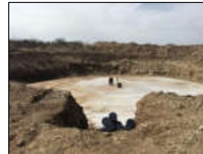
Excavation et béton de propreté Source : Artifex 2018
