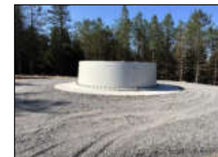
Fondation remblayée Source : Artifex 2018
