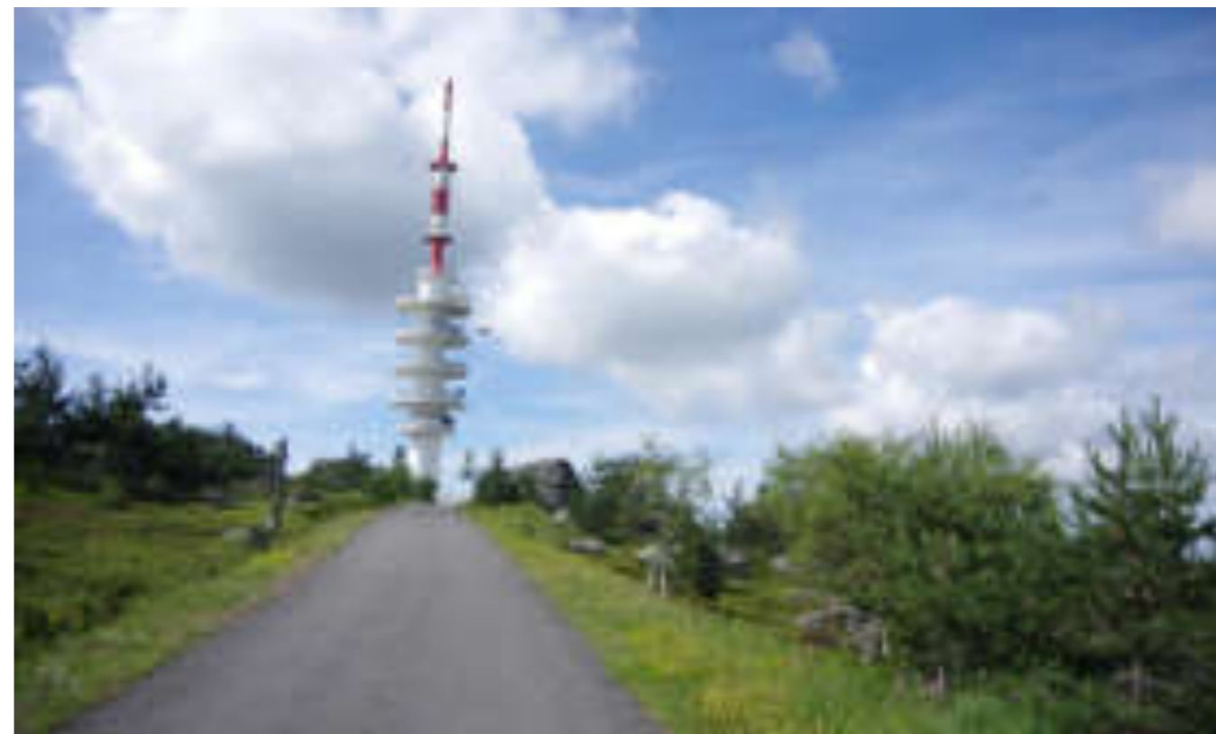
Vue de l'antenne du truc de Fortunio depuis de chemin d'accès, au milieu de la lande granitique
