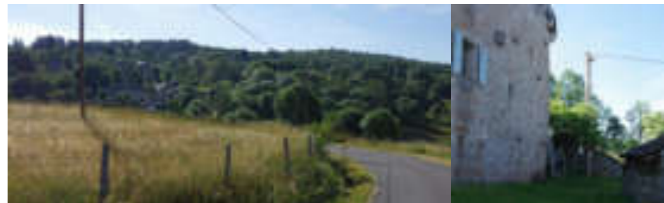
Le hameau de la Chazé, visible depuis ses abords et Le portail de la ferme de la Chazé, intégré dans la trame bâtie du groupe d'habitations
