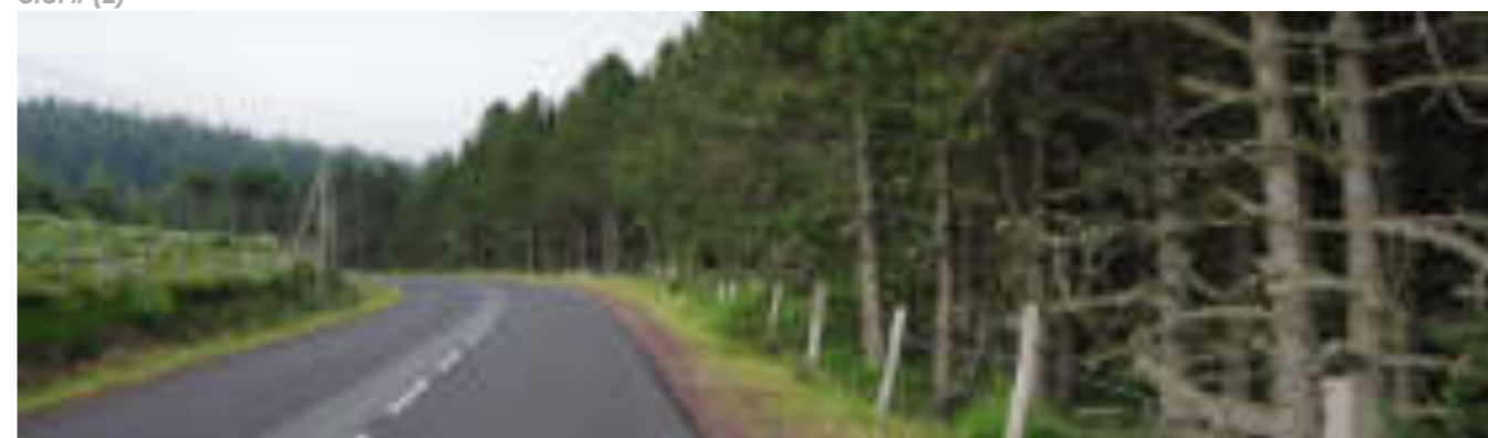
Vue refermée depuis un axe secondaire, la D345, circulant en fond de vallée
