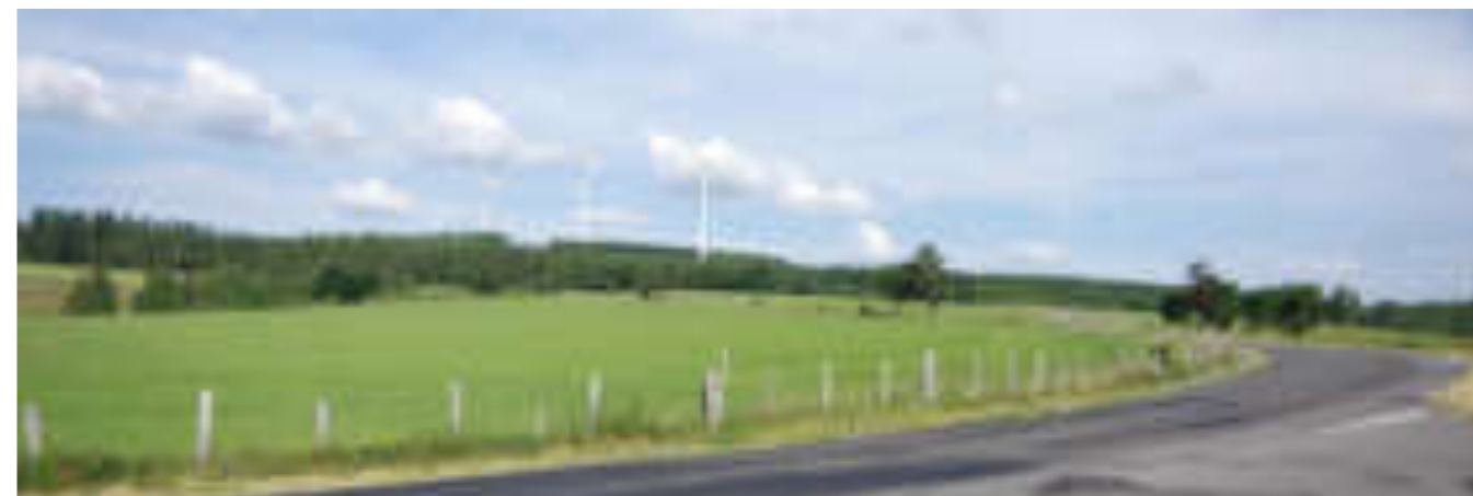
Le parc de Lou Paou, visible partiellement depuis le fond de la vallée, près de Chauvet
