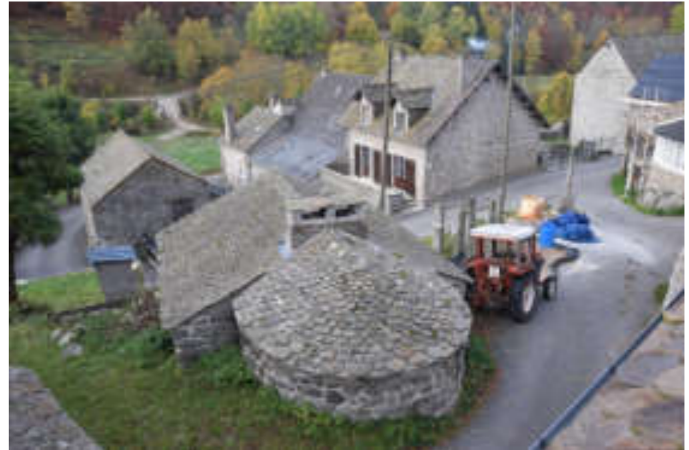
Exemple de four à pain et de ferradou (Coulagnes-Hautes)
