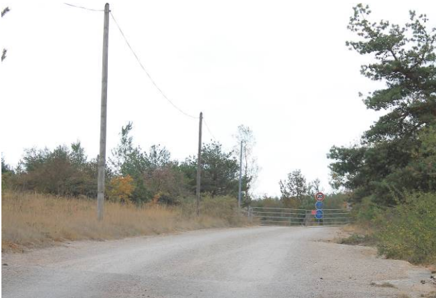
Vue sur la piste principale d'accès au site
