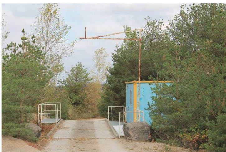
Prise de vue 5 : Vue sur le pont bascule et le local associé
