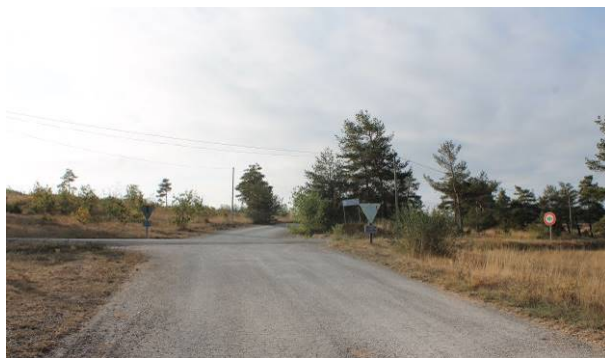
Vue sur l'arrivée – intersection avec la voie communale reliant le bourg du Masegros et celui de Recoules de l'Hom (tonnage limité à 19 t au-delà de l'accès au site vers Recoules) – Vue 4
