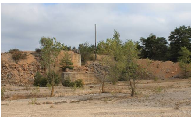
Vue sur les anciennes installations fixes en angle sud-est
