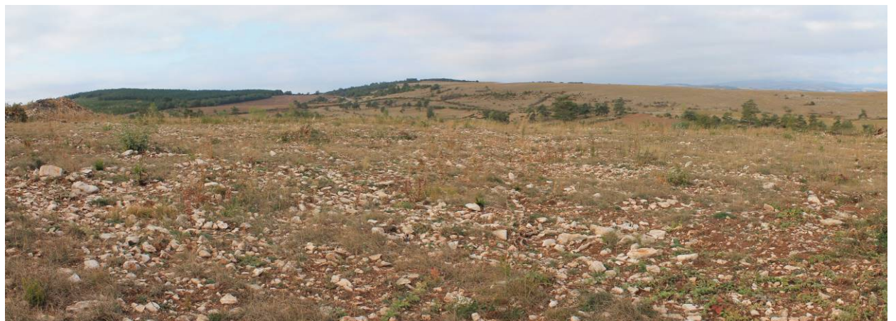
Vue sur les terrains restant à exploiter à l'ouest des fronts de taille actuels (emprises anciennement décapées délimitées par un merlon périphérique)
