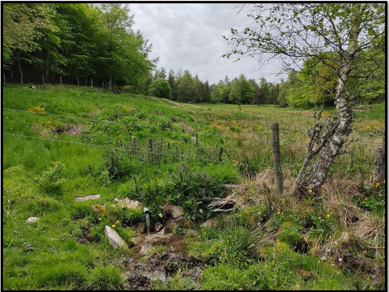
Figure 7 : Photo du rejet de la conduite (juin 2021)
