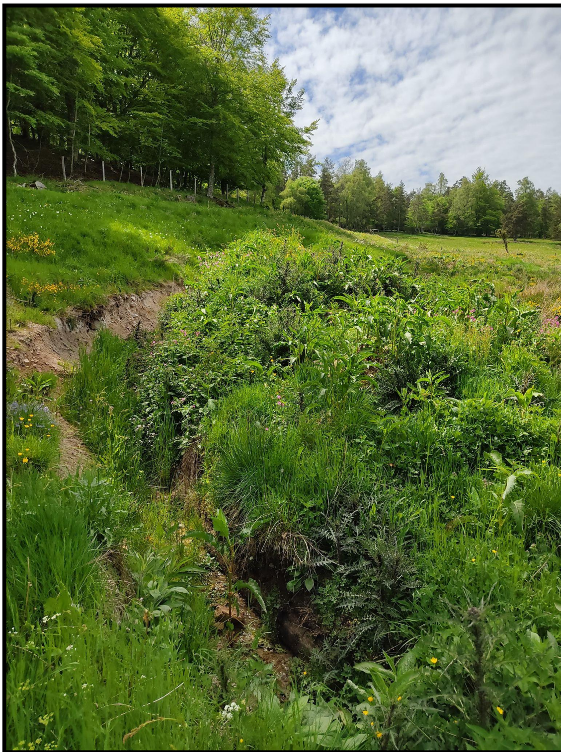
Figure 6 : Photo du dégagement avant rejet dans la conduite (juin 2021)
