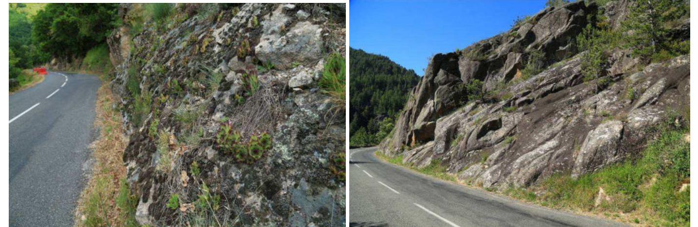
Milieux rocheux en bordure de la RD998
