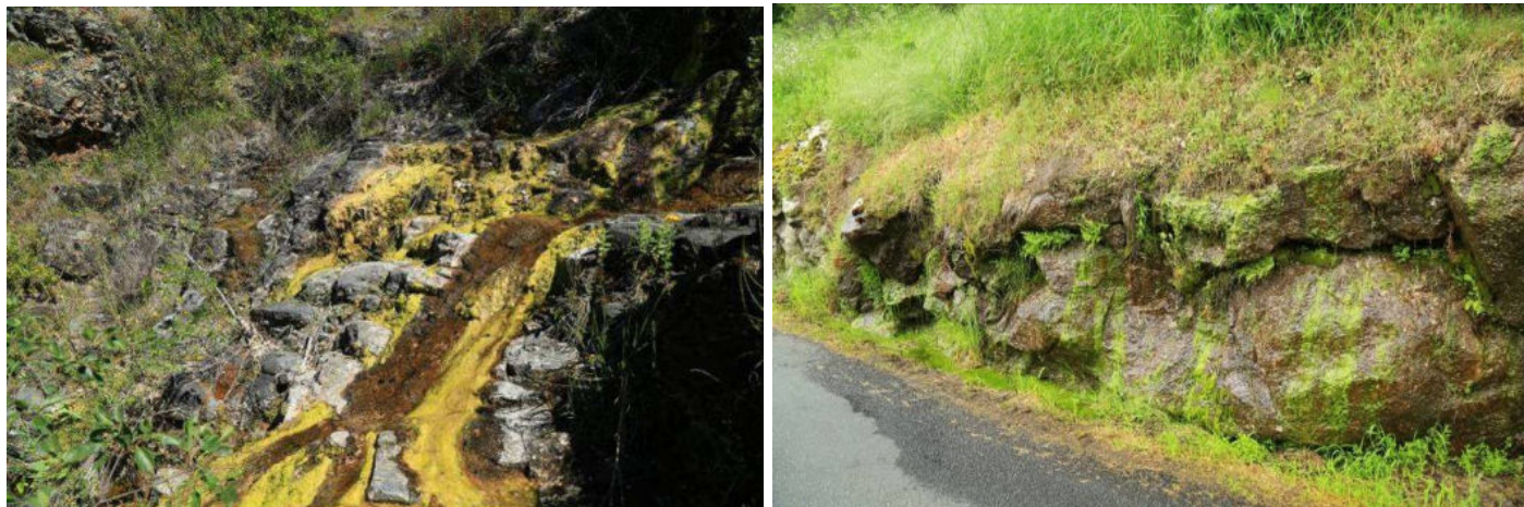
Suintement en fond de talweg recouvert de cyanobactéries
