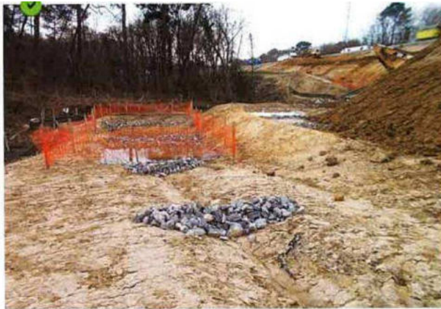
Fossé équipé de seuils en série en amont immédiat d'un piège à sédiments.
