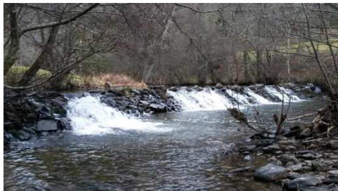
Vue de la Colagne au droit de la nouvelle prise d'eau sur la Colagne au niveau du seuil des « Valettes » (Source : Cereg Ingénierie, 2015)
