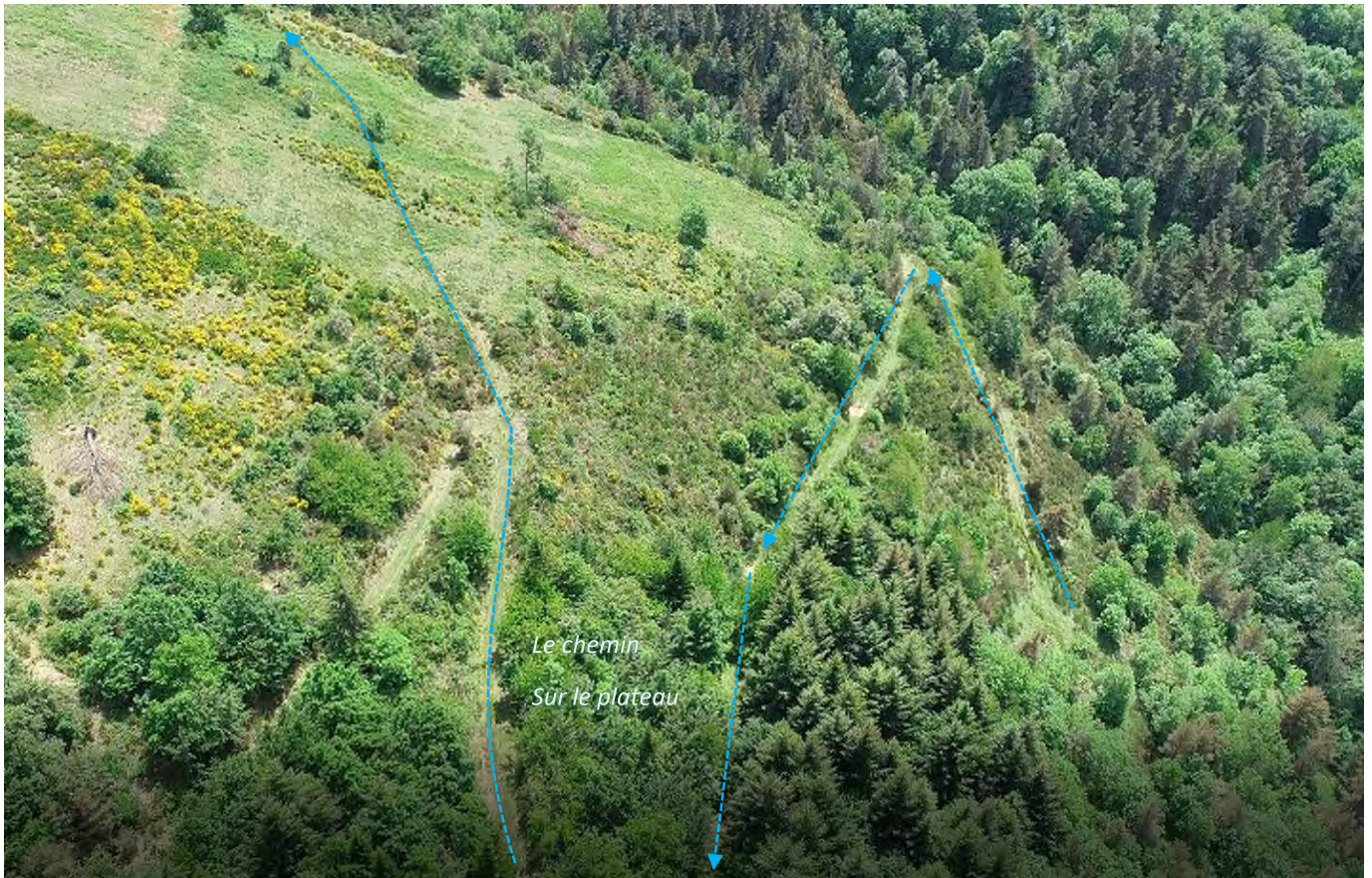
Illustration 46 : Tracé de la canalisation d'adduction sous chemin (photographie CEREG, mai 2020)
