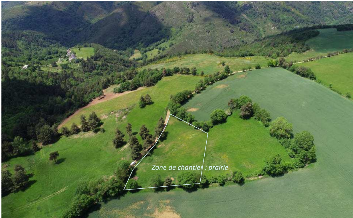
Illustration 48 : Implantation de la future station de potabilisation (photographie CEREG, mai 2020)
