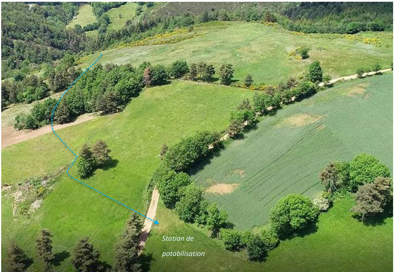
Illustration 47 : Tracé de la canalisation d'adduction sous chemin (photographie CEREG, mai 2020)
