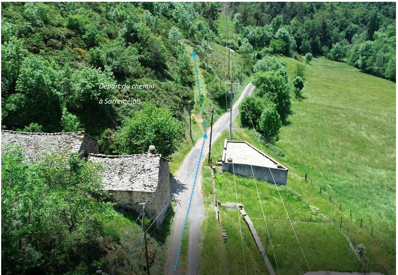
Illustration 45 : Départ du tracé de la future canalisation d'adduction (photographie CEREG, mai 2020)
