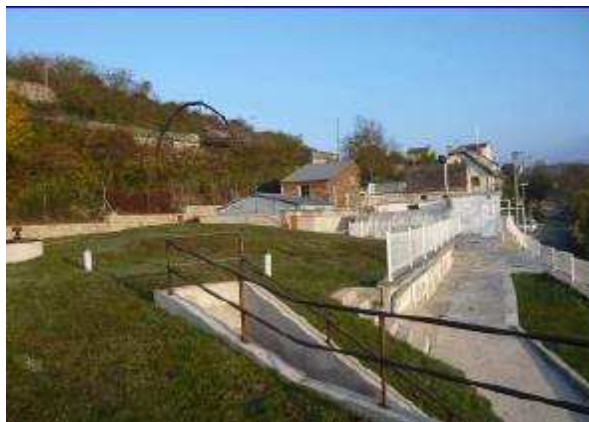
Illustration 6 : Photographie de la station de potabilisation actuelle de Marvejols (source : SDAEP, Cereg Ingénierie, 2008)
