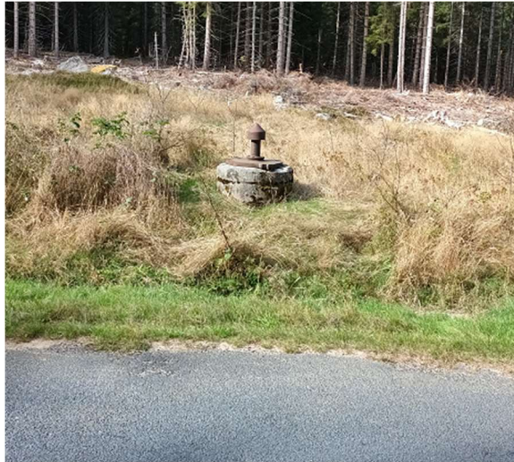
Vue du captage de Brenac 7 depuis la voie communale n°12
