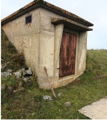
Réservoir du CHAYLA D'ANCE
