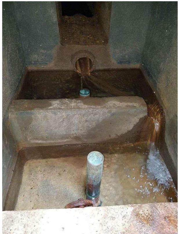
Figure 11 : Photo de bac de prise et de décantation du captage de SAINT-PRIVAT AMONT
