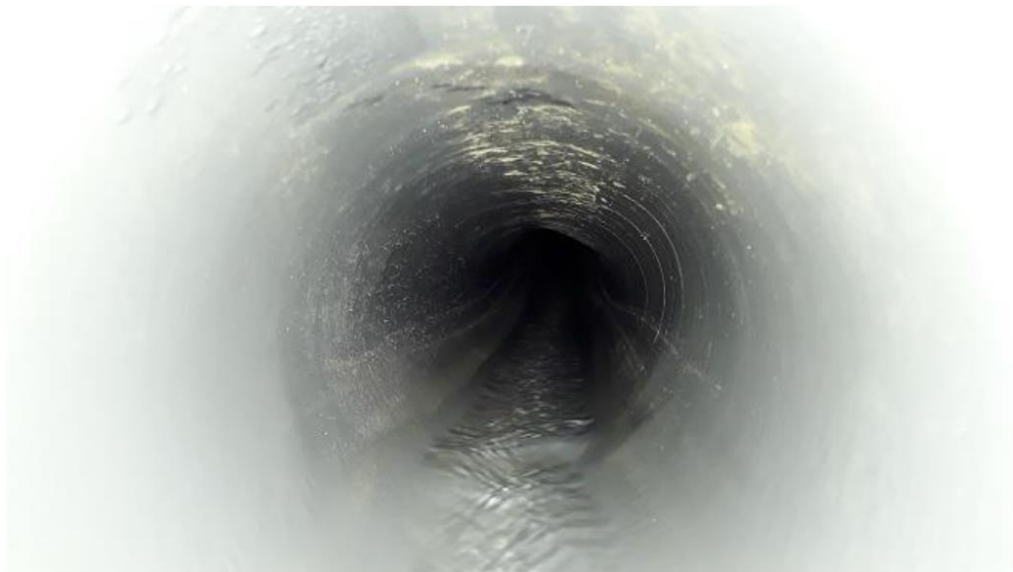
Planche photographique n°4 : intérieur de la canalisation d'amenée en PVC de diamètre 200 mm
