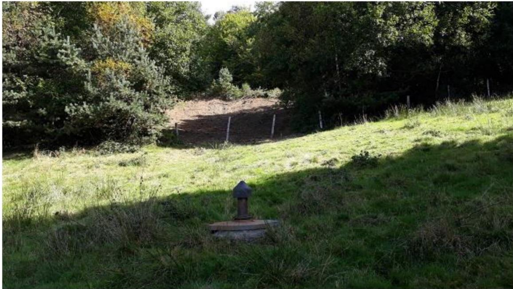
Planche photographique n°1 : vue générale du captage « Amourettes Amont », de sa chambre de captage et de la zone de drainage et de son environnement proche vers le nord-est
