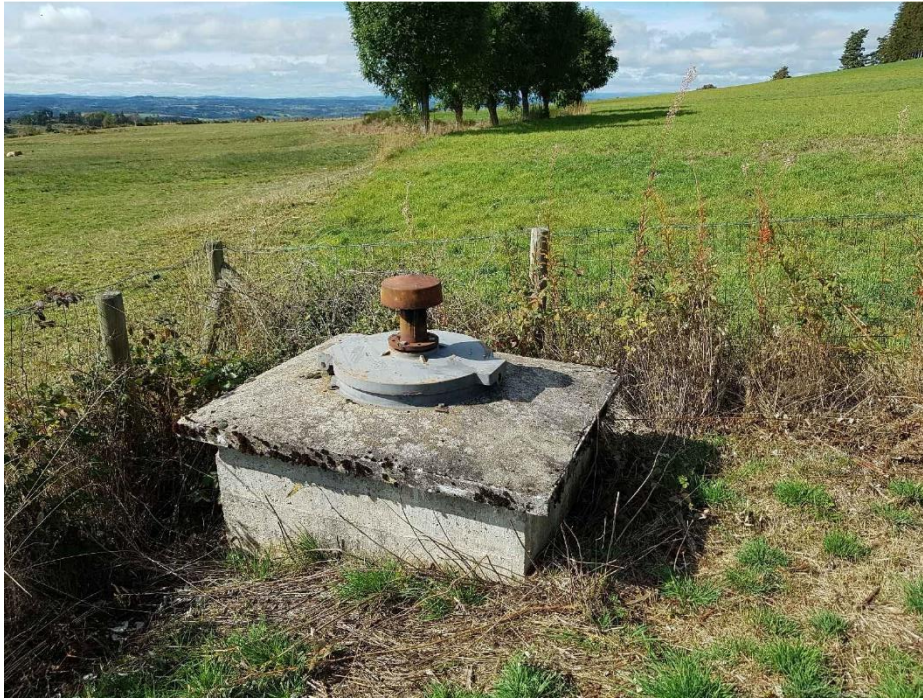
Figure 51 : Photo de regard aval du captage de VARENNES
