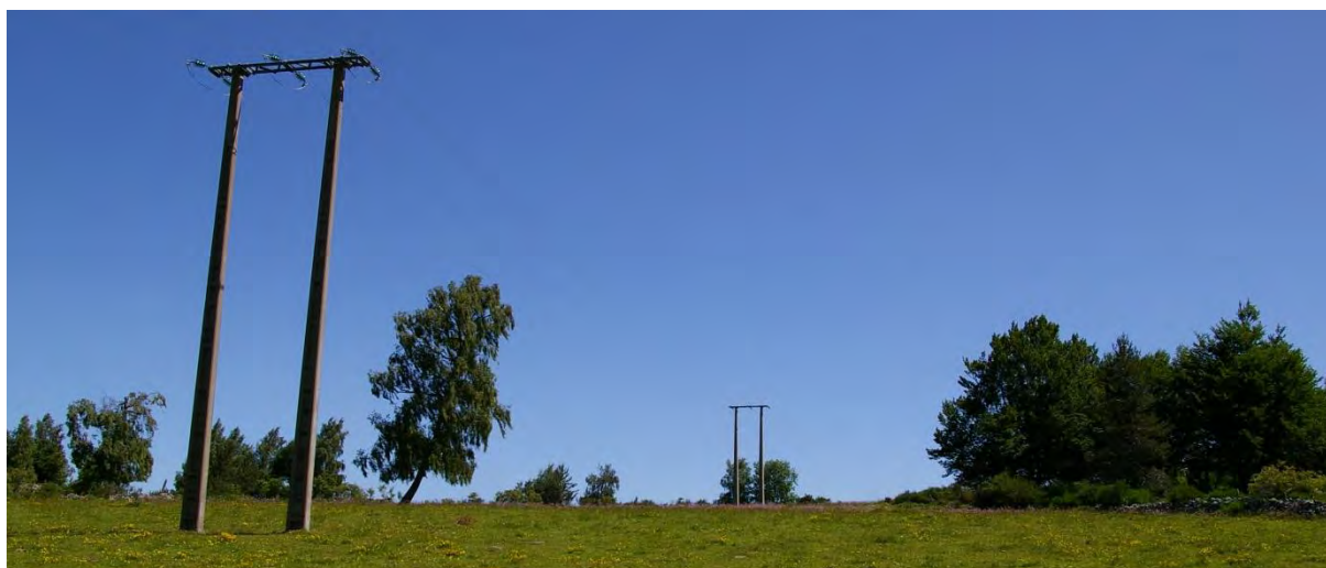
Figure 50 : Ligne HTA ERDF présente à l'ouest de la carrière actuelle.
