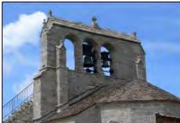
Figure 47 : Clocher en peigne de l'église de Fau-de-Peyre
