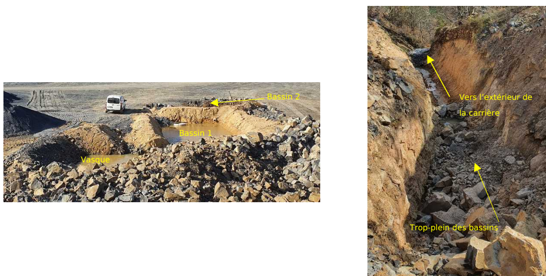
Photo des bassins (à gauche) et du trop-plein (à droite).
