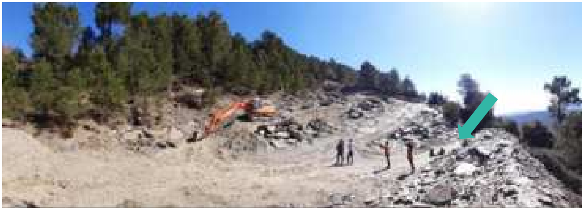
Illustration 7 : Vue de la carrière à partir de la zone de rétention en partie basse avec le chemin d'accès fléché (Cereg, Mars 2021)
