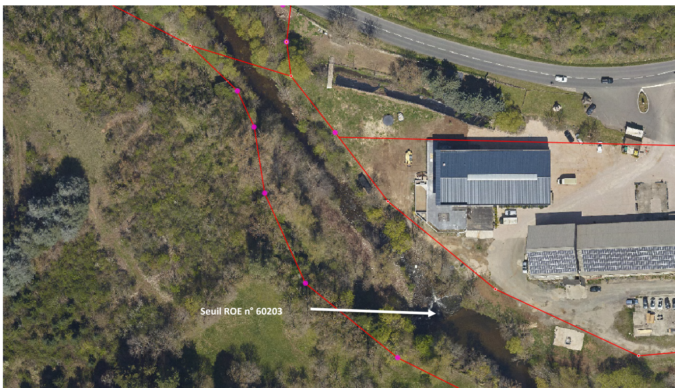
Illustration 10 : Vue aérienne du seuil ROE n° 60203 (Source : CEREG, mai 2023)
