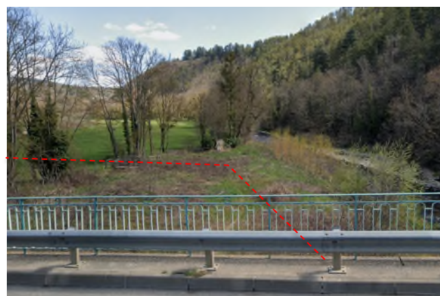
Illustration 4 : Zone de passage du futur réseau enterré de refoulement vers le poste de relevage principal, en rive droite de la Colagne (source : Google, Avril 2021)
