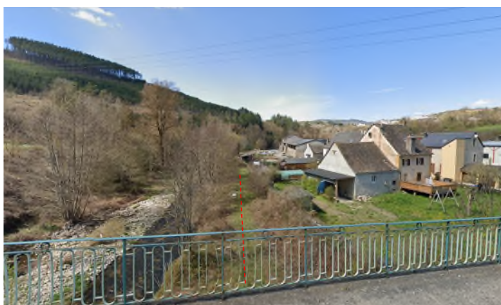
Illustration 3 : Zone de passage du futur réseau enterré de refoulement au départ du poste de relevage de la ZAC de Pont-Pessil, en rive droite de la Colagne (source : Google, Avril 2021)
