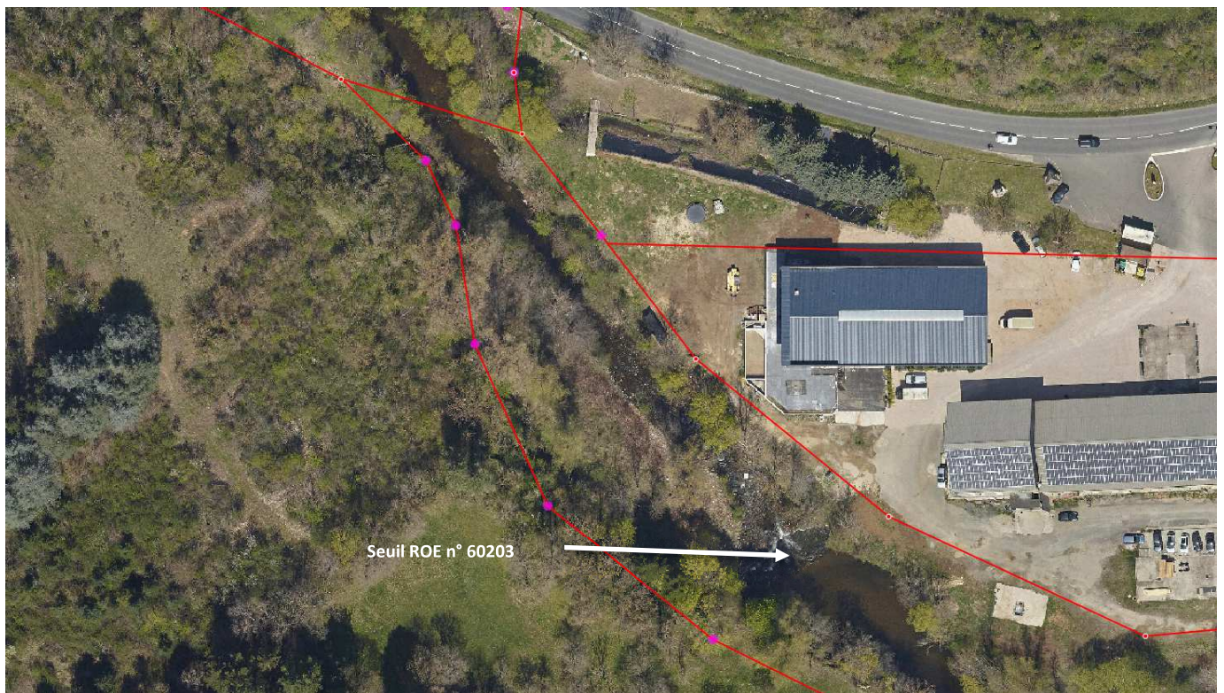
Illustration 21 : Vue aérienne du seuil ROE n° 60203 (Source : CEREG, mai 2023)
