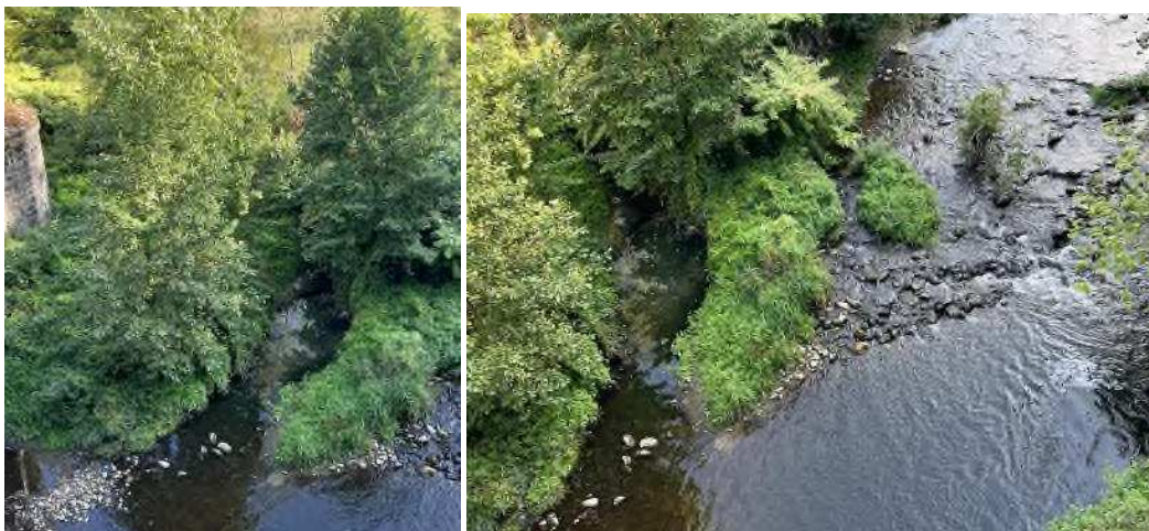
Illustration 11 : Vues depuis le pont de la RD808 sur l'écoulement de l'exutoire pluvial existant vers la Colagne, utilisé comme point de rejet du futur déversoir d'orage du PR principal (source : CEREG, Août 2022)
