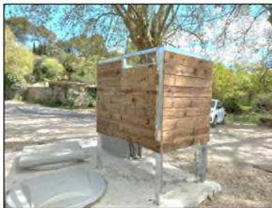
Illustration 14 : Exemple de bardage bois autour d'un poste de relevage (source : CEREG, Août 2022)
