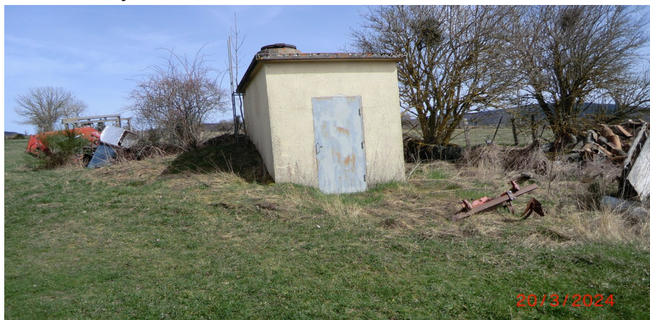
Vue du réservoir de Varennes
