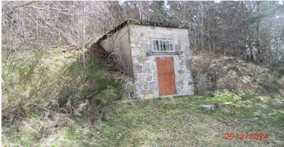
Vue du réservoir d'Amourettes
