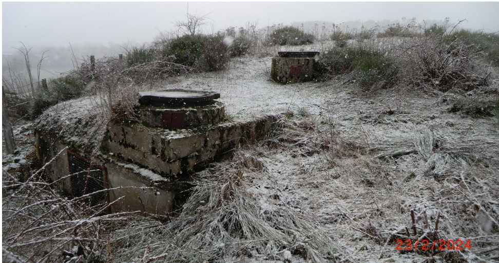
Vue du réservoir de Julianges
