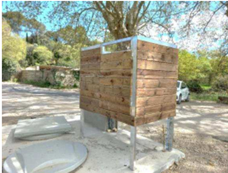
Illustration 36 : La plateforme métallique avec habillage bois prévu au niveau du PR secondaire de la ZAC de Pont-Pessil
