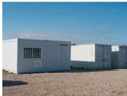
Photographie 1 : Installation de la base-vie (Source : EDF Renouvelables)
