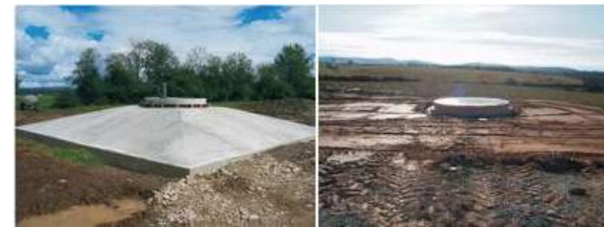
Photographie 4 : Massif béton terminé (à gauche), état final après remblaiement (à droite)
