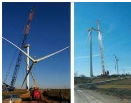
Photographie 6 : Montage du rotor (à gauche), montage « pale par pale » (à droite) Source : EDF Renouvelables
