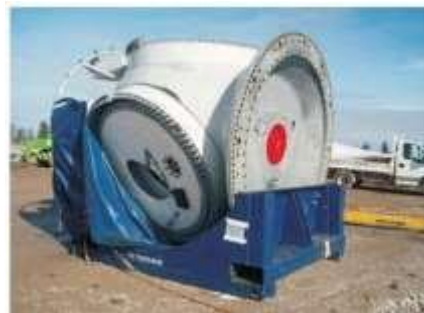
Photographie 2 : Stockage d'un rotor sur une plate-forme
