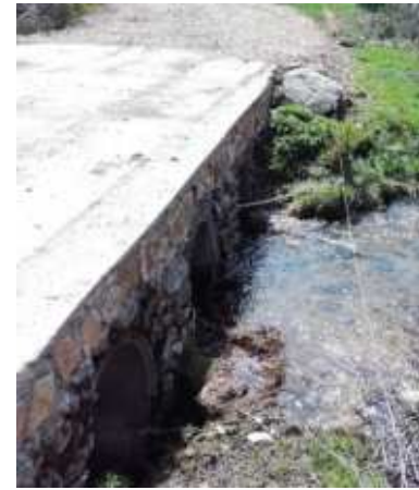
Figure 449: Exemple de travaux de renforcement de pont de franchissement par coffrage et jointement des fondations
