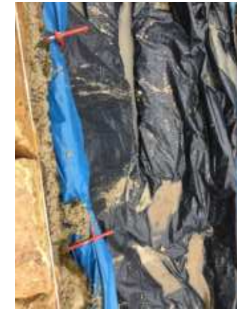
Figure 450: Mesures de protection du pont par bâchage au-dessus du cours d'eau
