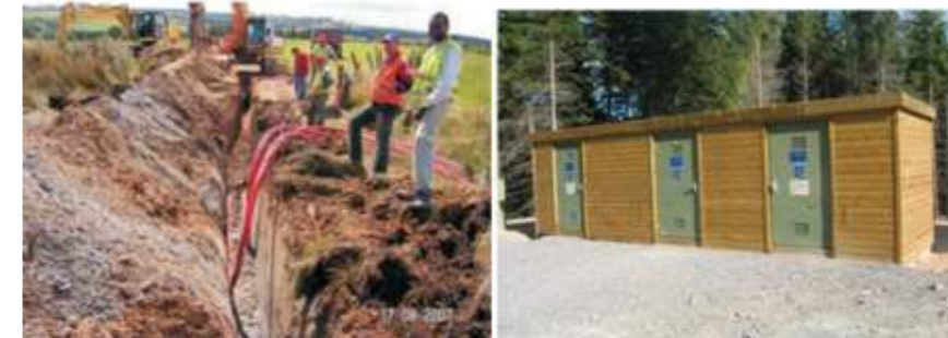
Photographie 7 : Déroulage et pose des câbles (à gauche), poste de livraison (à droite) Source : EDF Renouvelables
