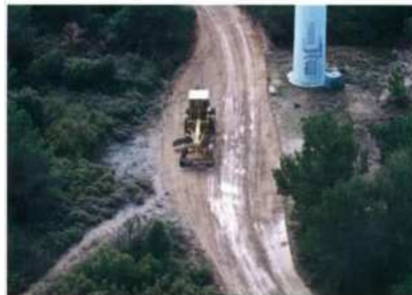
1 - Début des travaux et préparation des accès
