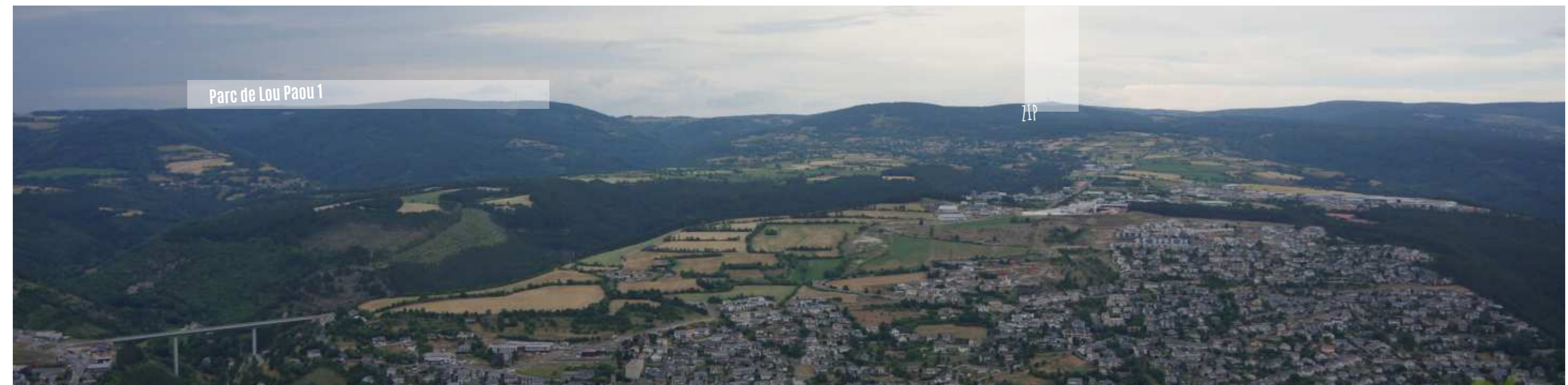
Depuis la table d'orientation sur les coteaux sud de Mende
