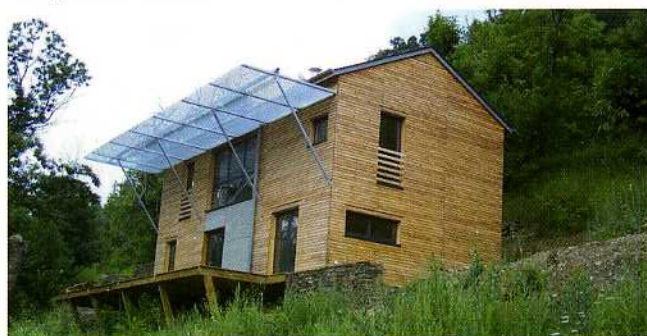
Maison en bardage bois, La Salle Prunet - Architecte : J.M. Priam, Le Compas dans l'œil
