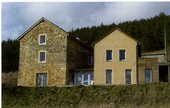
Construction mixte, La Capelle - Architecte : Marie-Claire Bessin
